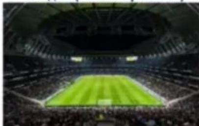
У стадиона два покрытия: когда необходимо, верхнее сворачивается, открывая второе при помощи 68 электродвигателей.
